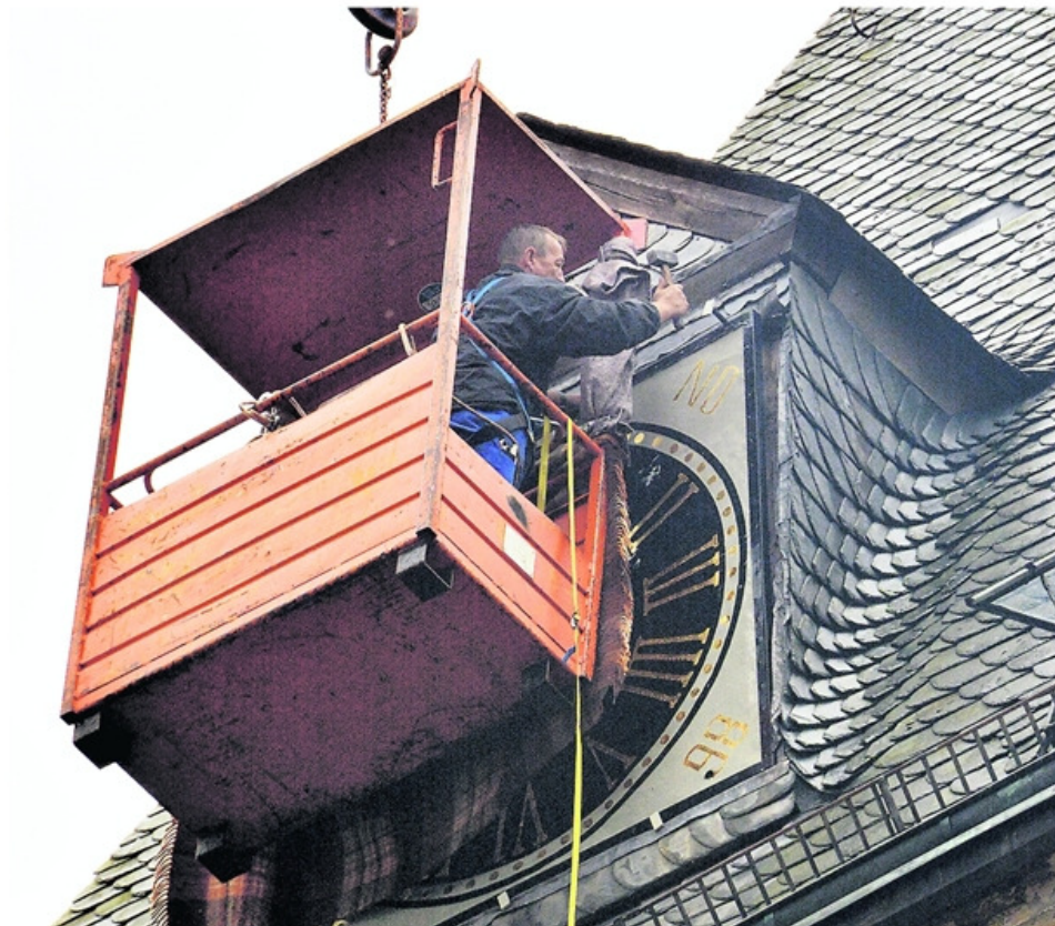
Noch ein Hammerschlag, dann hängt das erste der beiden restaurierten Zifferblätter am Westturm des Münsters. Wal
